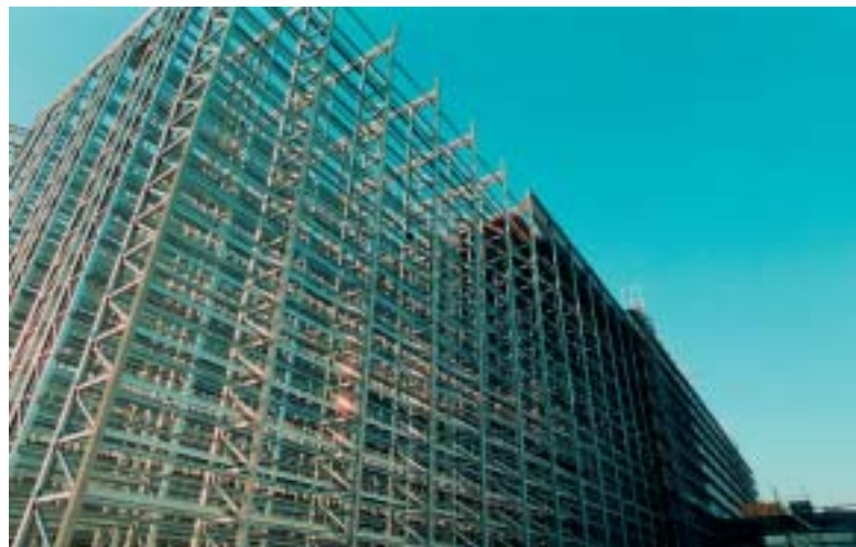
Bauphase Logistikzentrum mit Prüflabor der Firma Würth Holding GmbH
